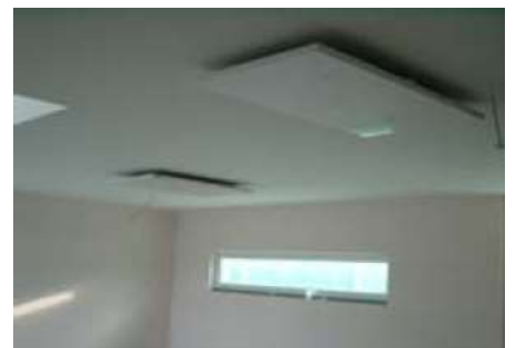
Bild 16: Nachdem der Maler ..., wurden die Marmorheizkörper unter die Decke ...
