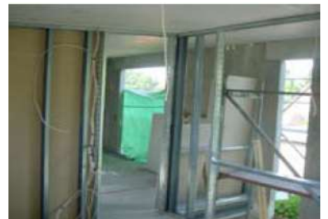
Bild 13: ... kann nun mit dem Innenausbau begonnen werden
