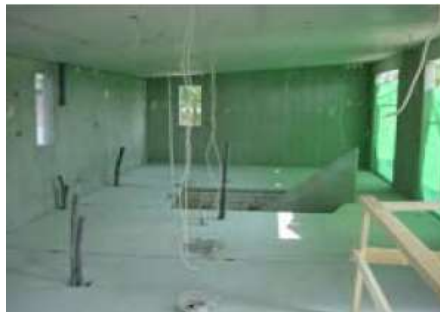
Bild 12: Nach der Verlegung der restlichen Elektroleitungen ...
