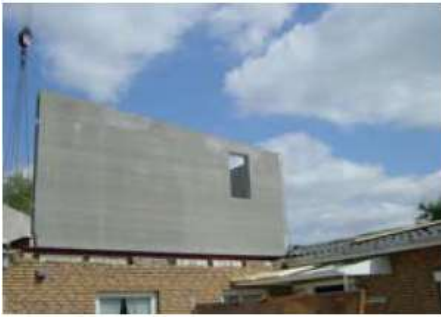
Bild 5: Die ersten Wände der Geschossaufstockung der Wohnung II stehen
