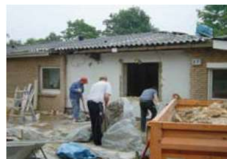
Bild 3: Beginn der Abbrucharbeiten für die Öffnung des Wohnraums zum Anbau
