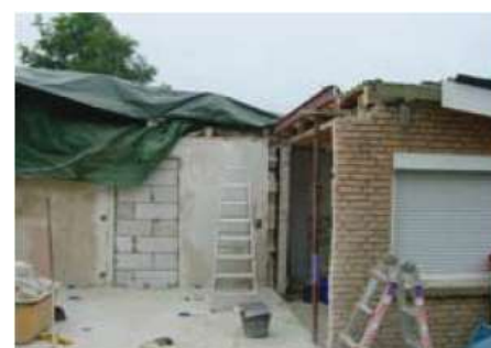
Bild 4: Die Abbrucharbeiten sind fast abgeschlossen, der alte Zugang geschlossen
