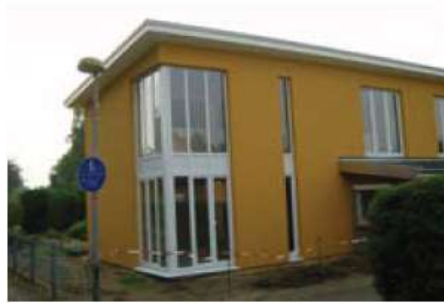
Bild 18: Fertige Süd-West-Ansicht mit dem großzügigem Fensterbereich zur Terrasse und Galerie im Obergeschoss
