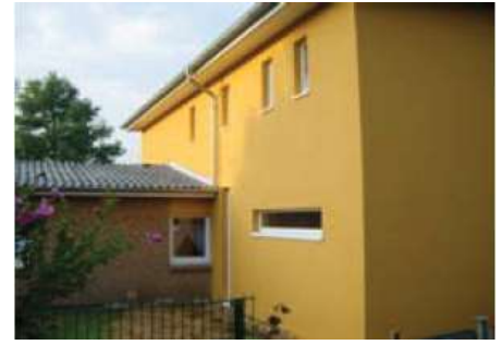
Bild 19: Ansicht von Norden mit kleinen Fenstern
