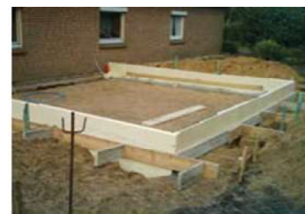
Bild 2: Vorbereitung der Bodenplatte für den Anbau
