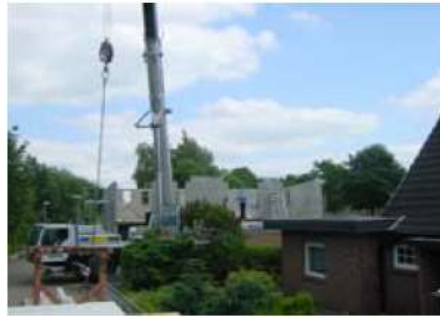
Bild 6: Der Telekran setzt Wand für Wand und die untere Lage der zweischaligen Betondecke
