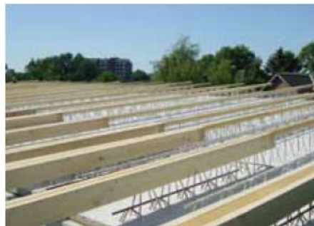
Bild 9: Die Massivdachtafeln sind verlegt, nun erfolgt die Komplettierung des Daches ...
