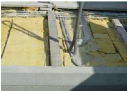
Bild 8: Die Dämmung auf der unteren Decke wird als Resonanzkörper verlegt, ebenso die Elektro- und Sanitärgrundleitungen. Nun kann mit der Verlegung der oberen Estrichtafel begonnen werden
