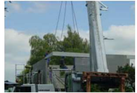
Bild 7: Die letzten Betonfertigteile werden gesetzt
