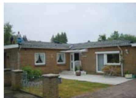
Bild 1: Ausgangssituation: Winkelbungalow mit flacher Dachneigung
